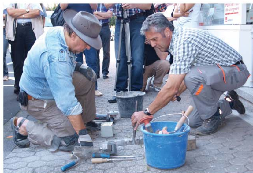
Werner Pehl vom städtischen Bauhof (r.) unterstützte Gunter Demnig beim Verlegen der Stolpersteine. In der Bahnhofstraße wurden zwei Stolpersteine für Betty und Willy Stern verlegt. Ihr Enkel Gerald Stern lebt heute in England und förderte das Projekt Stolpersteine.
