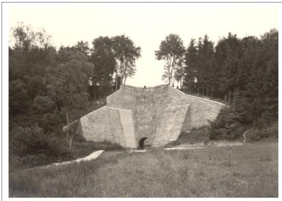
Das Foto 15 zeigt die Brücke im Jahre 1926. Dieses Jahr ist vermutlich das, in dem die Brücke zu dem Bauwerk ausgebaut wurde, wie es sich bis heute darstellt. 16
