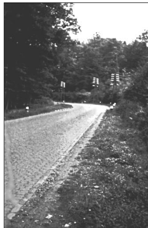
Auf dem Foto aus den 1950er Jahren ist zu erkennen, dass die Straße damals noch mit Kopfsteinpflaster befestigt war.
