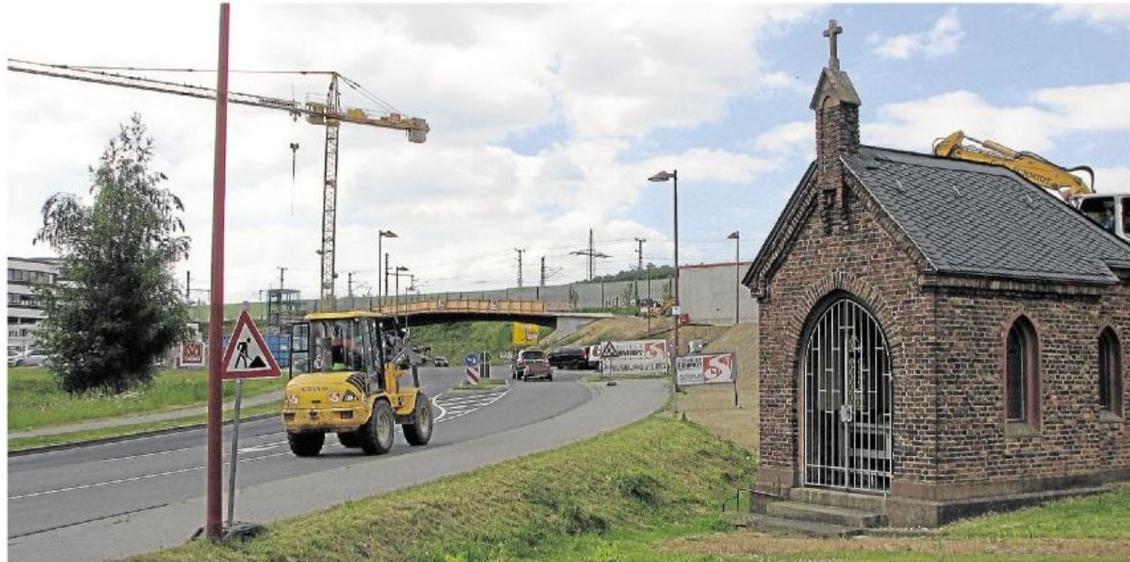
Etwas verloren wirkt die Kapelle in Allmannshausen zwischen vielen Baustellen. Die Anpflanzung neuer Linden ist aber bereits geplant. Foto: Thorsten Ferdinand
