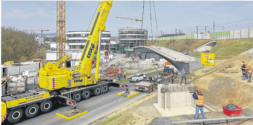
Tonnenschwere Brückenteile werden im Montabaurer ICE-Park mit einem Kran verladen und anschließend montiert.
