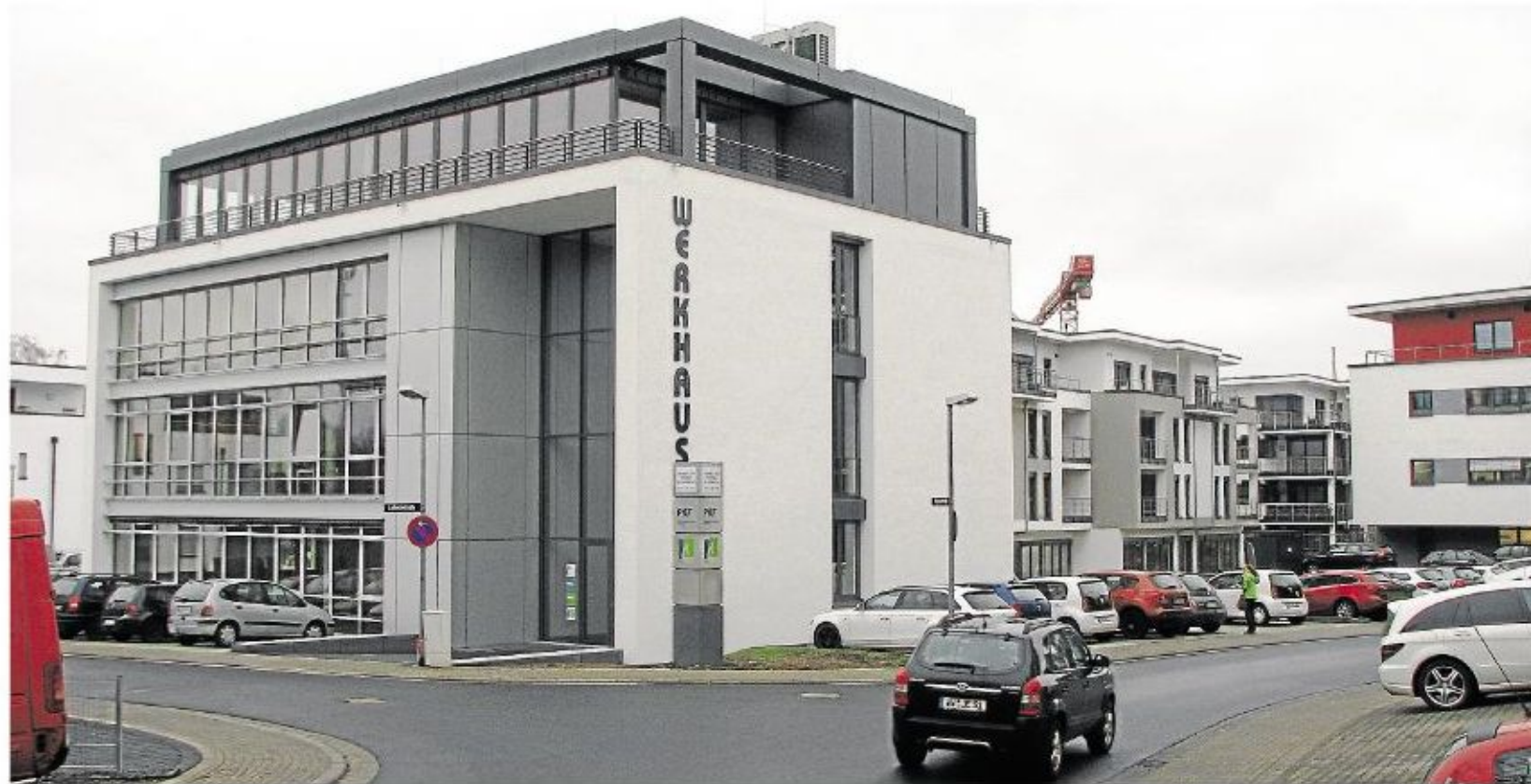
Eines der neusten Objekte im Montabaurer Aubachviertel ist das Werkhaus einer Bauherrngemeinschaft um Rita Weber. Es erinnert im Stil an die Bauhaus-Architektur aus Weimar und Dessau und wird ausschließlich gewerblich genutzt.
