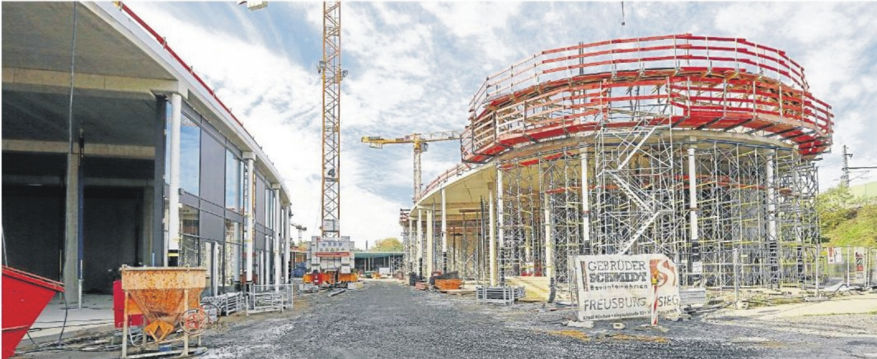
Die Arbeiten am Fashion Outlet Montabaur liegen voll im Zeitplan. Ende des Jahres soll der Rohbau stehen.
