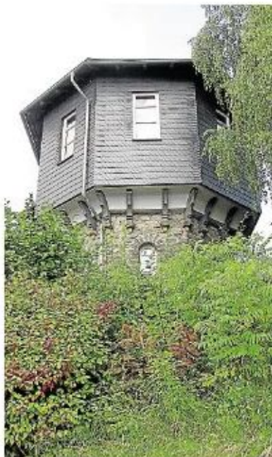
Der denkmalgeschützte Wasserturm im Montabauren Aubachviertel bleibt als historisches Schmuckstück erhalten. Foto: Thorsten Ferdinand
