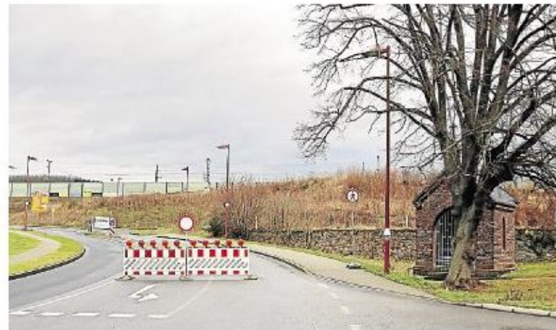
Endstation Allmannshausen: Der Montabaurer ICE-Bahnhof ist voraussichtlich bis Ende April nicht über die Alleestraße zu erreichen. Foto: Olaf Nitz
