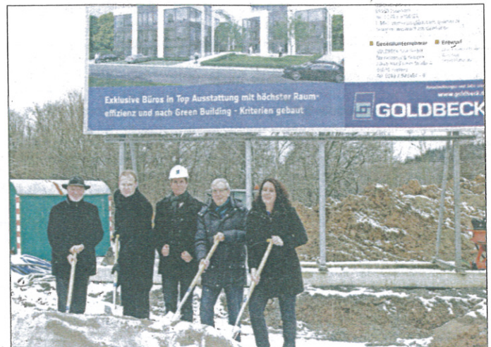
Spatenstich im Aubachviertel (v.l.) Bürgermeister Edmund Schaaf, Bauherr Dr. Marc Fischer, Bauleiter Marco Bayer (Fa. Goldbeck), Stadtbürgermeister Klaus Mies und Lydia Berressam von der Wirtschaftsförderung der VG Montabaur.
