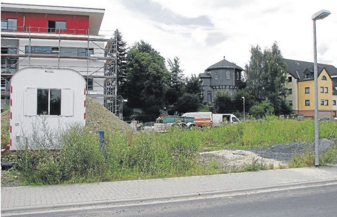
Blick von der Aubachstraße in Richtung Werkstraße: Auf dem Grundstück gegenüber des Wasserturms wird in zwei Jahren das Objekt der Vermögensberatung Böker & Paul entstehen.
