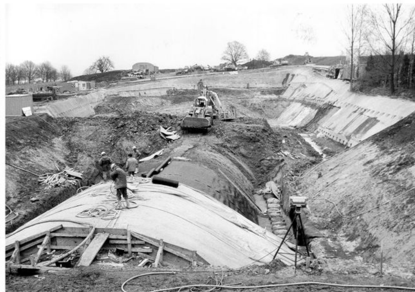
Die vielen Tunnels, durch die heute die ICes den Westerwald durchqueren, wurden damals zum Teil in offener Bauweise (wie hier ein Stück des mehr als drei Kilometer langen Dernbacher Tunnels), meist aber im unterirdischen Vortrieb erbaut.
