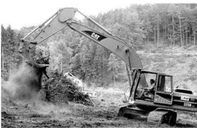
Die ersten Bagger rückten 1997 an, um die Bäume wegzuräumen, die der ICE-Strecke im Weg standen, wie hier in der Hermolder.
