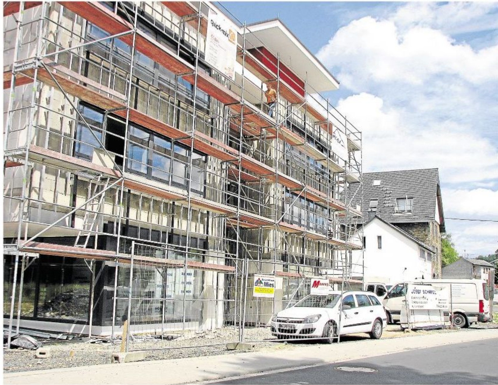
Eines der ersten Objekte im neuen Aubachviertel ist ein Geschäftsgebäude an der Werkstraße. In unmittelbarer Nähe befindet sich der alte Bahnhof. Der besondere Clou der neuen Bauweise ist das Energiekonzept.
