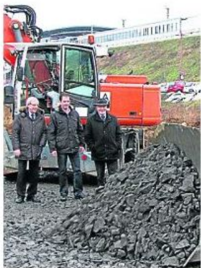
Am Montabaurer ICE-Bahnhof wird Boden aufgeschüttet. Foto: Ferdinand
