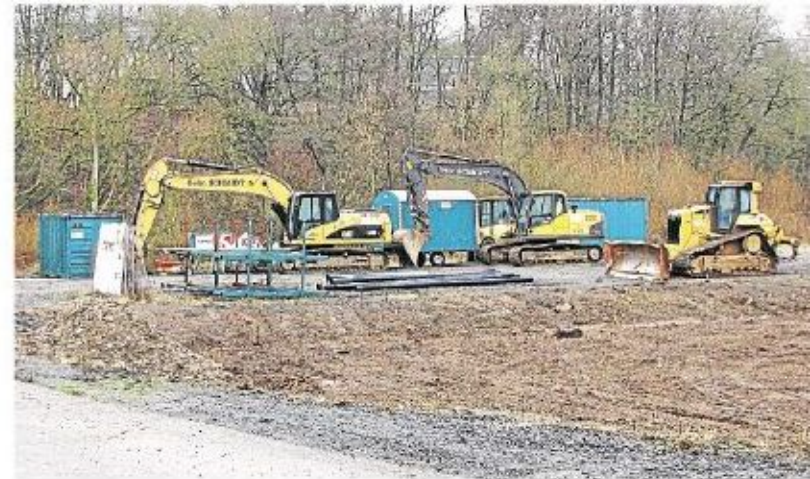
Das FOC-Grundstück im ICE-Park muss mit Erde aufgefüllt werden. Die entsprechenden Arbeiten beginnen Anfang Januar.
