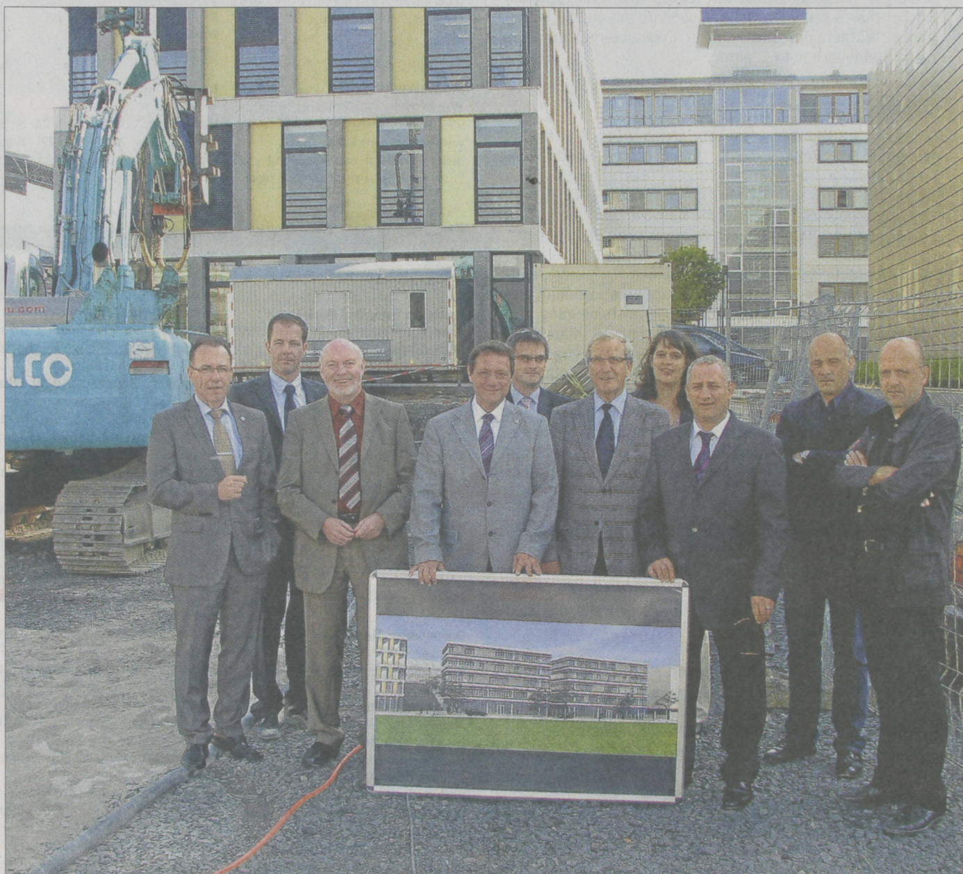
Der ICE-Park in Montabaur wächst. Gestern fiel auf der Baustelle an der Bahnallee der Startschuss für die Bürogebäude 5 und 6. Die Vertreter der Kommunalpolitik freuen sich hierüber ebenso wie die verantwortliche Immobilienfirma Sket. ■ Foto: Ferdinand
